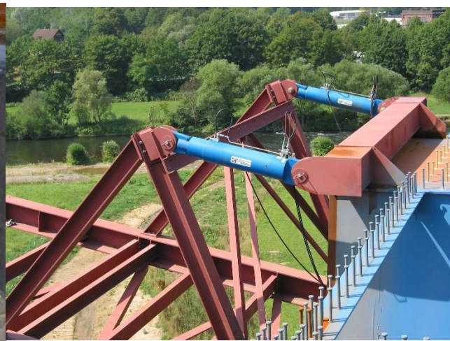
Schnabel-Hub-Vorrichtung An den Vorbauschnabel angeschraubte hydraulische Hubelemente
