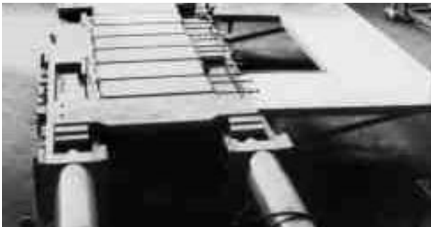
Pfeilerverschub-Anlage Für hohe, schlanke Pfeiler
